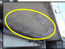
柏山こ道橋のコンクリート損傷部分を修繕
