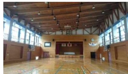
湖南小中学校体育館の照明をLED化
