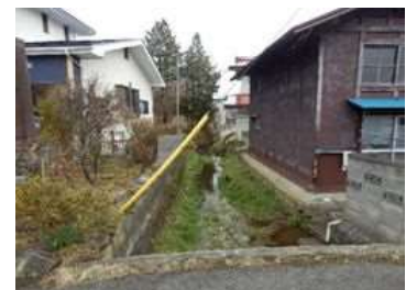
仲川 (湖南町福良地内) 護岸工 L ≒ 110m
