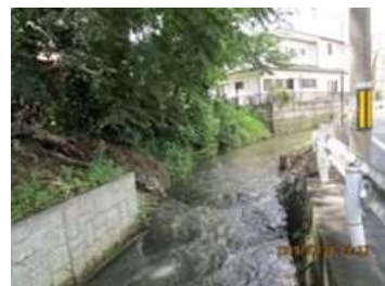
大槻川 (大槻町字下町地内) 護岸工 L ≒ 180m
