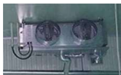
【更新する冷却機器】 (室外機：上・送風機：下)
