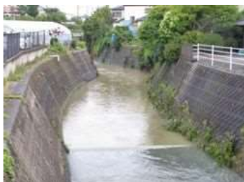
亀田川 (富田町字大島前地内) 根固工 L ≒ 100m
