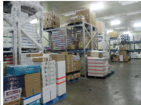
【水産棟 超低温冷凍庫内の様子】
