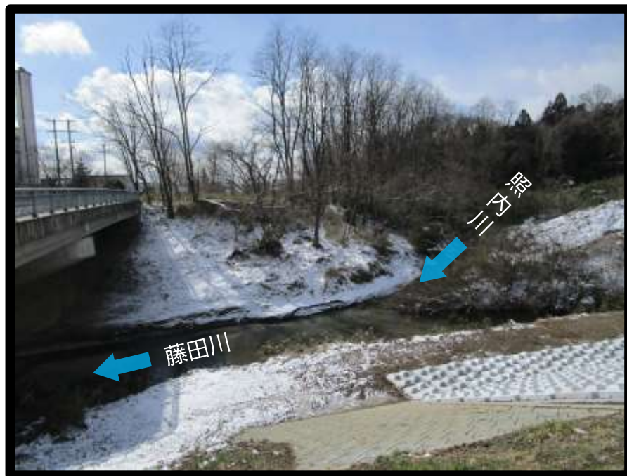
準用河川 照内川（一級河川 藤田川合流部）
