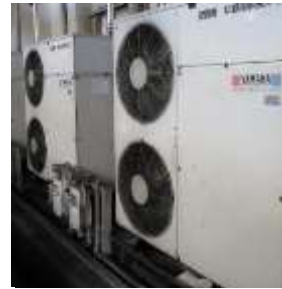
【既存空調・室外機】
