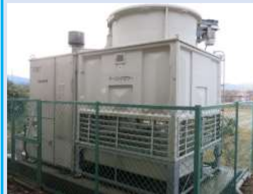
(冷温水発生装置)
