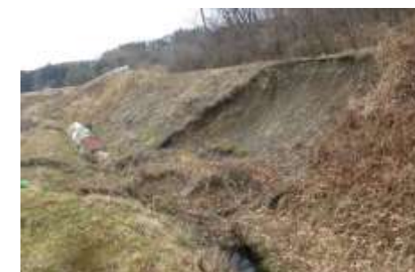
法面が崩壊した中井田大島 1号線 (中田町高倉)
