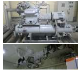
【既存冷凍機・送風機】
