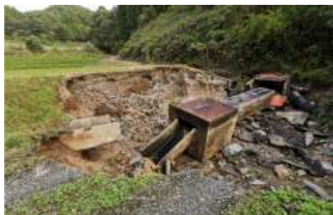
崩落した水田と水路 (中田町高倉)
