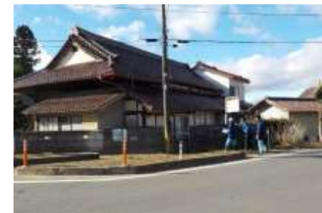
損壊家屋の建物調査 (田村町下行合)
