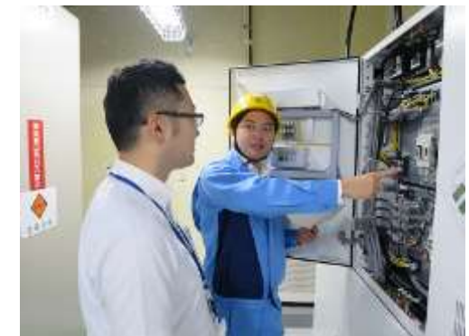
VPP機器設置の様子（中央公民館）
