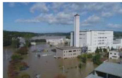
浸水した富久山クリーンセンター (富久山町福原)
