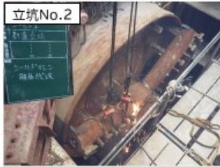
シールド掘進機解体状況
