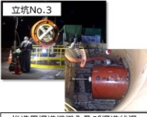
推進用掘進機搬入及び掘進状況
