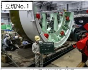
シールド掘進機搬入状況
