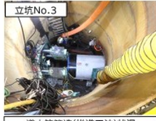
導水管築造(推進工法)状況
