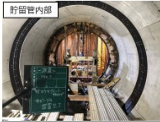
シールド掘進機撤去完了状況
