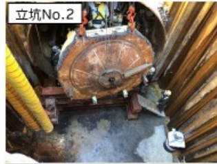
シールド掘進機解体状況
