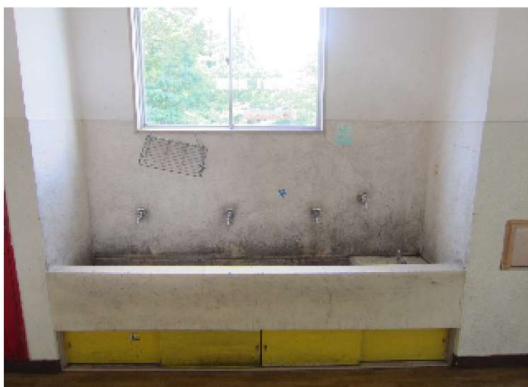
(手洗場改修前)
