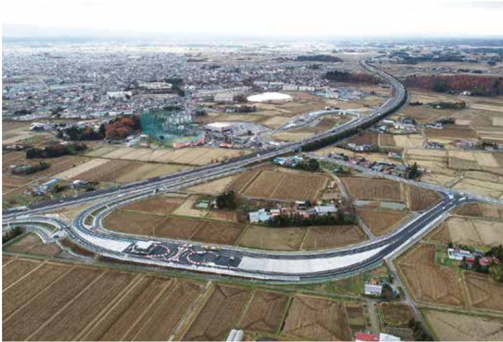
郡山中央スマートインターチェンジ
