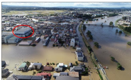
神明下地区浸水状況 赤丸が帝京安積高校体育館
