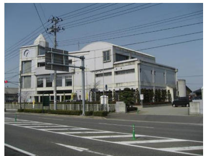
安積行政センター全景
