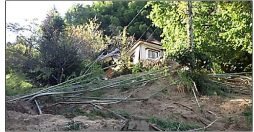
写真⑤ 川曲地区 住宅損壊
