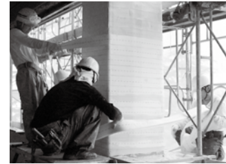
▲柱に巻きつけ、建物の強度を上げる包帯補強
