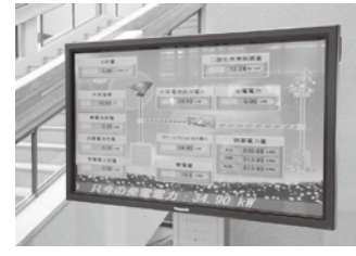
▲太陽光発電による発電量がわかるモニター（正面入口に設置）
