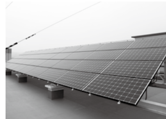
▲最大 50kW の発電が可能な太陽光発電パネル
