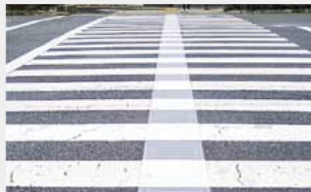
仙台市のエスコートゾーン設置例 （国土交通省ウェブサイトより）
