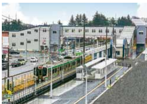
エレベーター設置など UDに配慮された郡山富田駅
