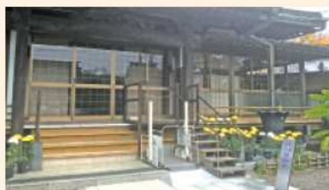
車いすのまま本堂に入れる電動昇降機 段差の低いゆるやかな階段
