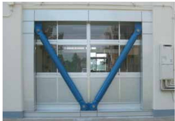
▼耐震化工事の例(建物)
