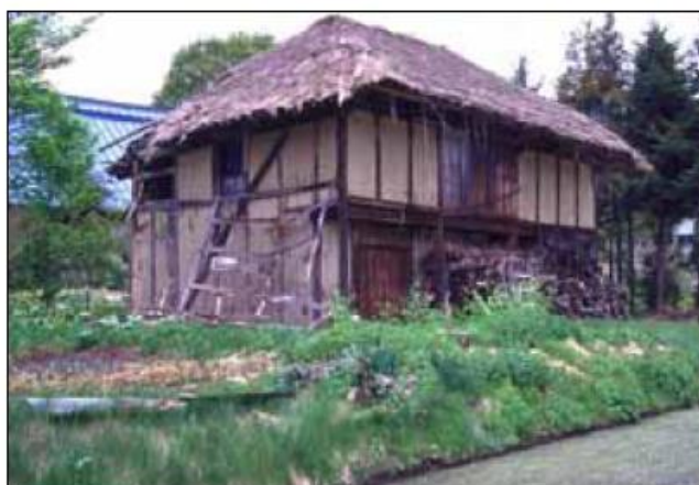
屋根材がワラの例
