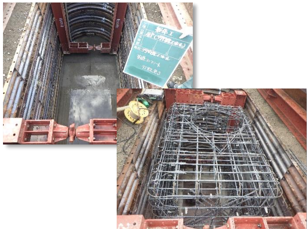
特殊人孔築造(基礎コンクリート工・配筋)状況
