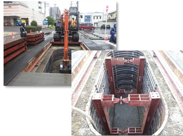
特殊人孔築造に係る掘削・仮設土留設置状況
