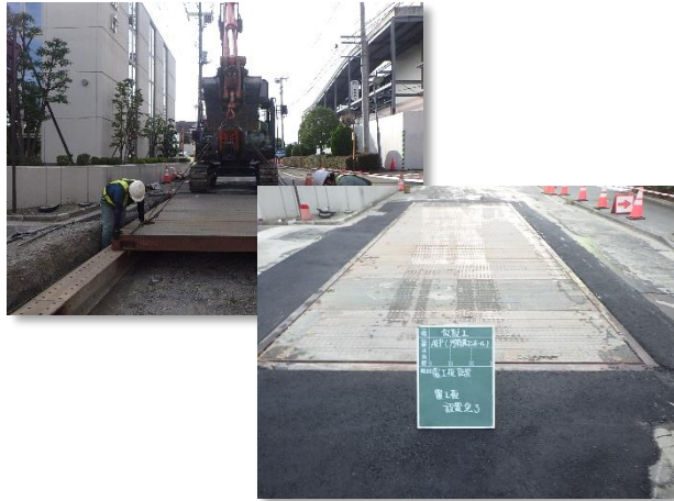
特殊人孔築造に係る覆工板設置状況
