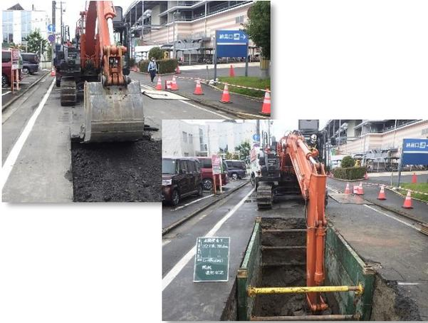
舗装取壊し、掘削・土留設置状況
