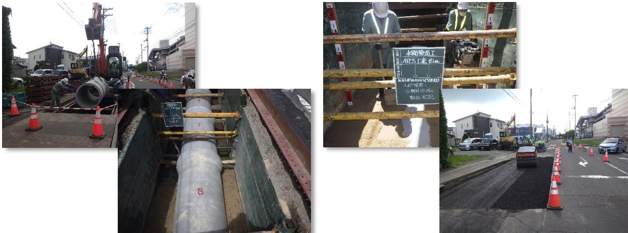
導水管(統合管)設置状況
