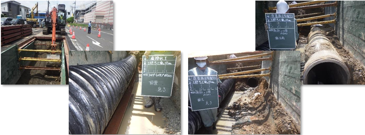
掘削・土留及び仮排水管設置状況
