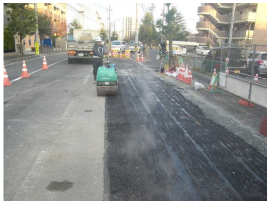
舗装仮復旧状況
