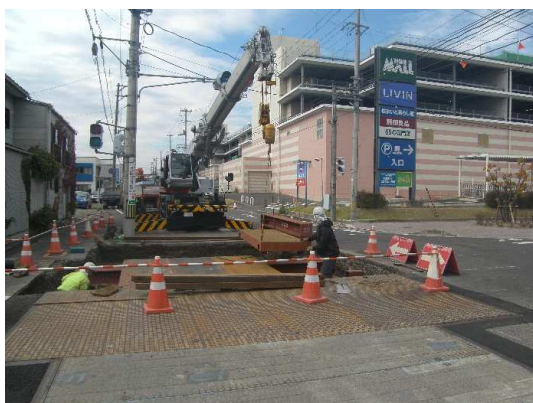
覆工板設置状況
