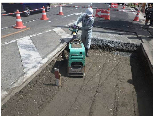
埋戻し(転圧)状況
