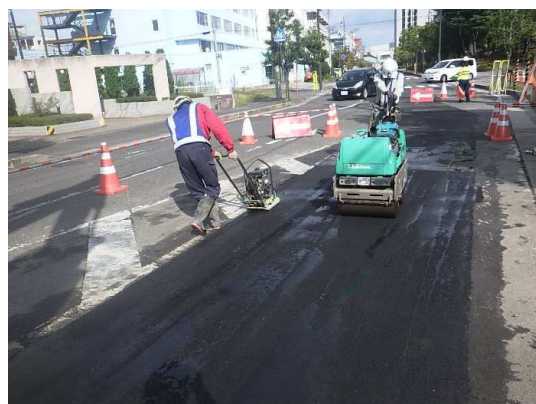
舗装仮復旧状況
