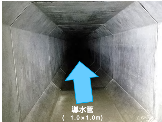
導水管完了(No.2特殊人孔より下流を望む)
