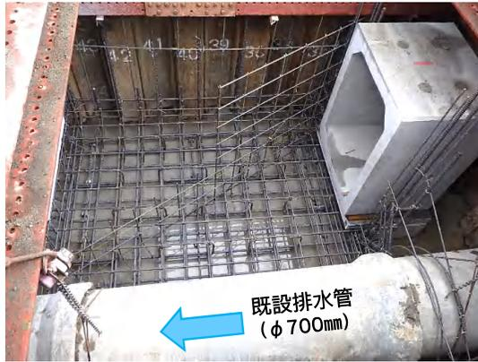
コンクリート打設(配筋)状況(No.2特殊人孔)
