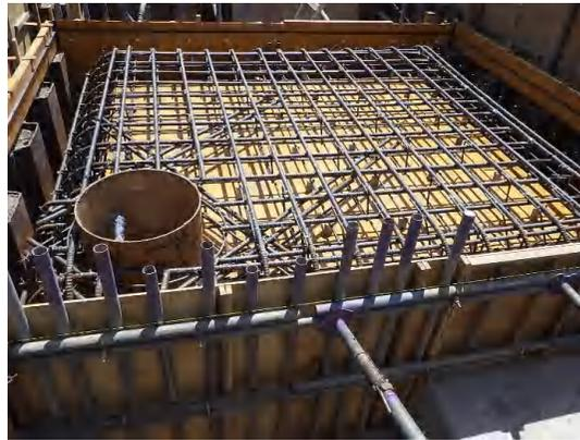
コンクリート打設(配筋完了)状況(No.2特殊人孔)
