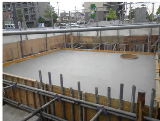
コンクリート打設完了状況(No.2特殊人孔)
