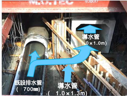
既設排水管一部取壊し完了状況(No.2特殊人孔)
