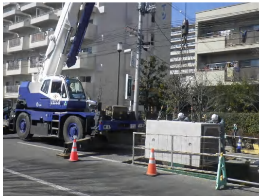
ボックスカルバート布設状況
