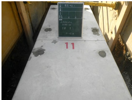
ボックスカルバート布設状況
