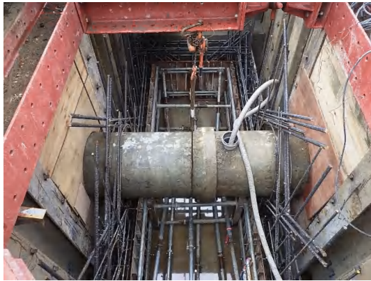
コンクリート打設(配筋・型枠)状況(No.1特殊人孔)
