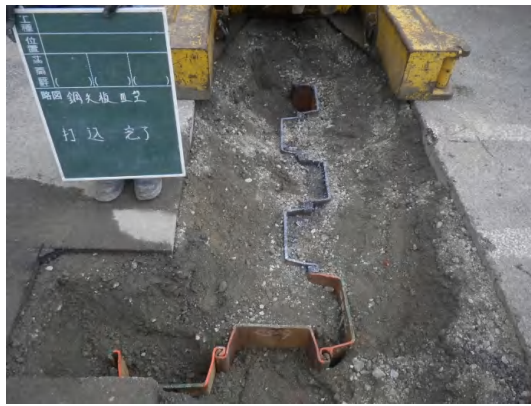
鋼矢板設置状況
