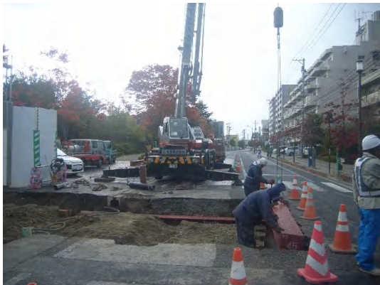
覆工板設置状況
