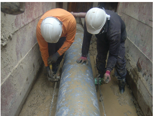
放流管布設状況
