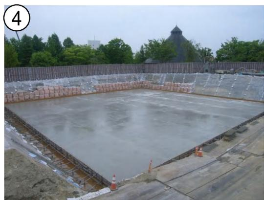
基礎コンクリート打設完了状況
