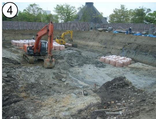
掘削状況(法面崩落防止のための大型土のう)
