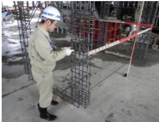
製品検査立会状況(配筋検査)
