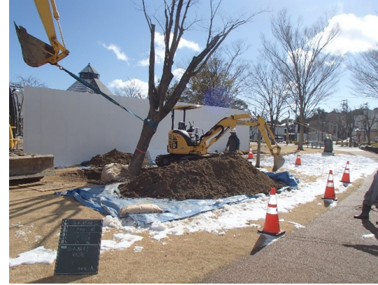
樹木移設状況
