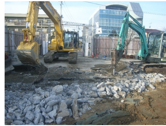
敷石撤去状況
