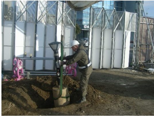
庭園灯撤去状況
