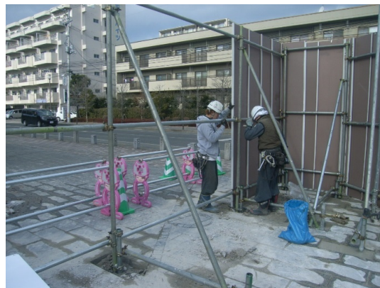
仮囲い設置状況
