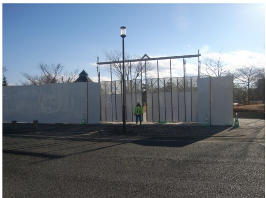
仮囲い設置完了（北側）
