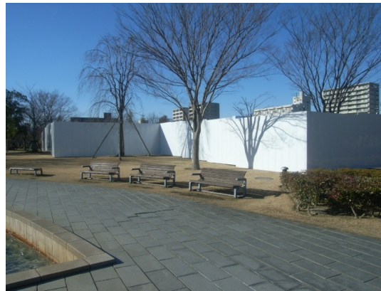
仮囲い設置完了（南側）
