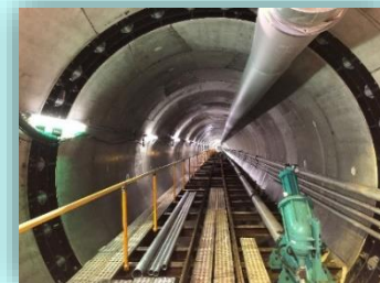
図景貯留管内部
