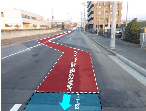
舗装仮復旧完了状況(下流側から上流側へ望む)
