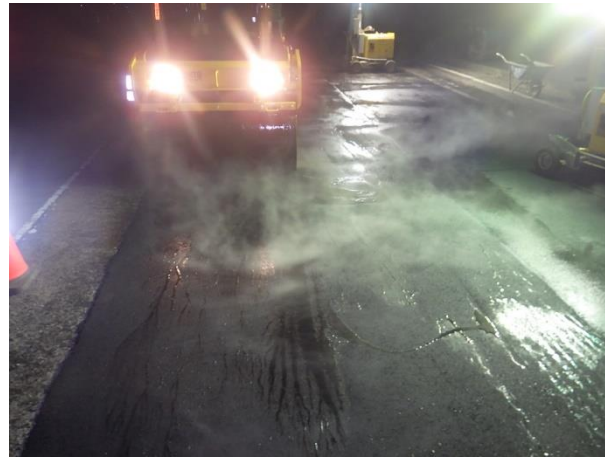
舗装仮復旧状況
