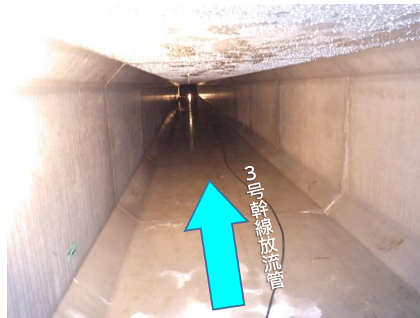
ホックスカバート内部状況(R3.2月時点)
