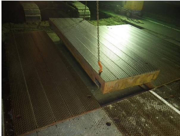
覆工板撤去状況
