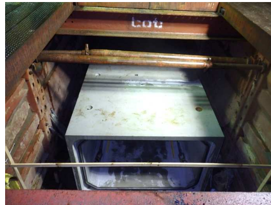
ボックスカルバート布設状況
