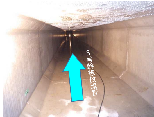
ボックスカルバート布設完了(内部)状況
