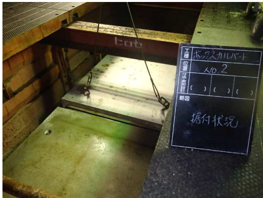
ボックスカルバート布設状況
