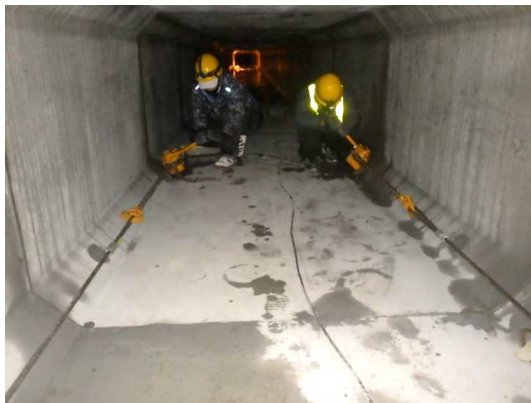
ボックスカルバート布設(内部)状況
