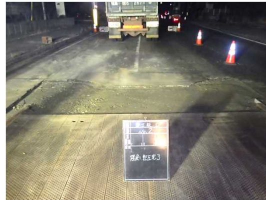
埋戻し(転圧)完了状況
