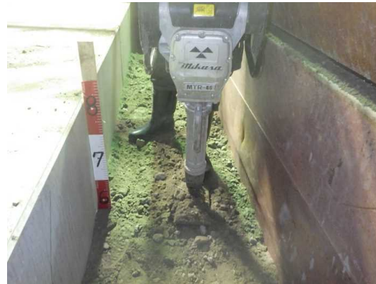
埋戻し(転圧)状況
