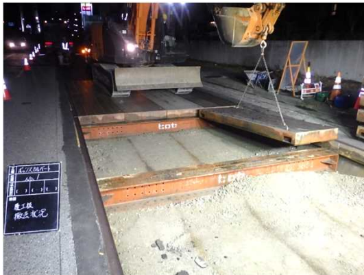
覆工板撤去状況
