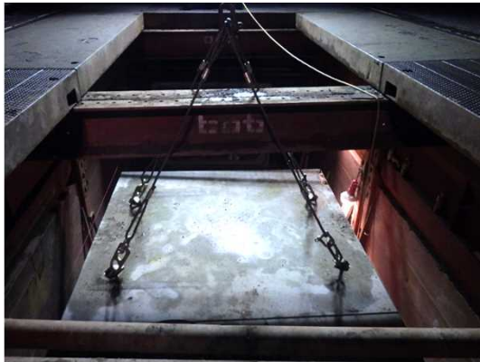
ボックスカルバート布設状況
