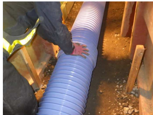
取付管設置状況
