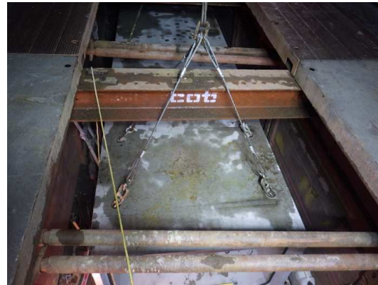
ボックスカルバート布設状況
