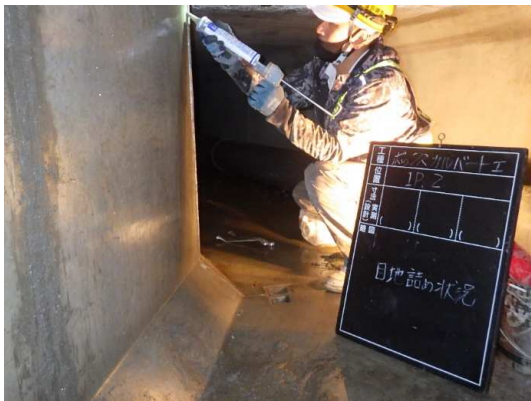
ボックスカルバート布設(目地工)状況
