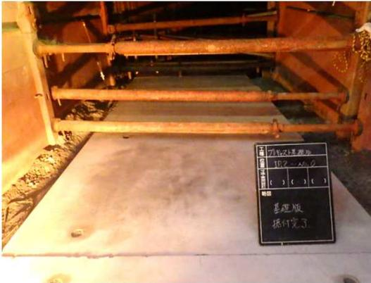
基礎工(プレキャストコンクリート板設置)状況
