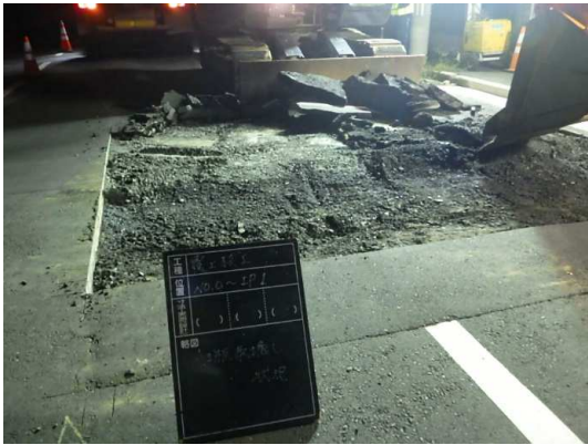
舗装取壊し状況
