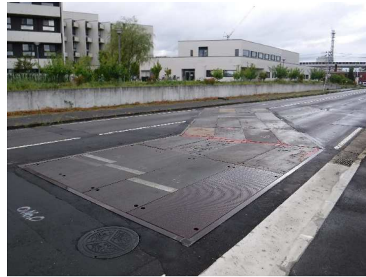
覆工板設置状況
