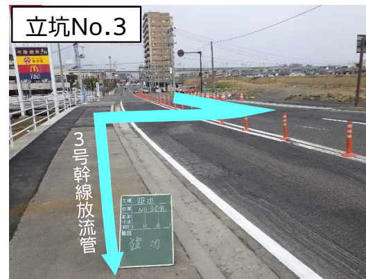
舗装仮復旧完了状況
