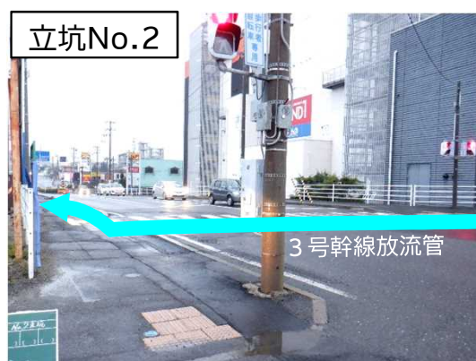
舗装仮復旧完了状況
