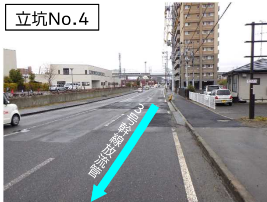
舗装仮復旧完了状況
