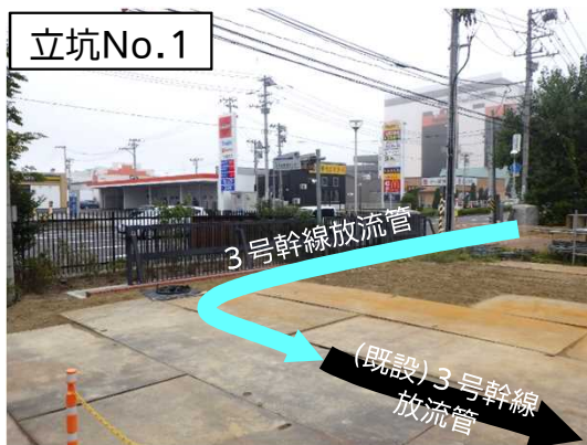
復旧状況(下水道管理センター内)
