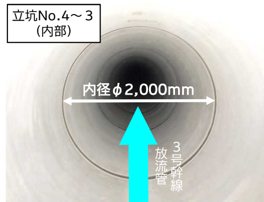
推進1-m管布設完了状況(R元年9月末時点)
