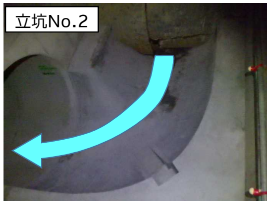
特殊人孔築造(ｲﾝﾊﾞｰﾄ)状況(上流側を望む)
