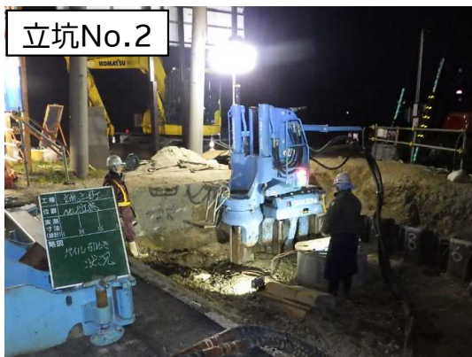
仮設土留撤去状況
