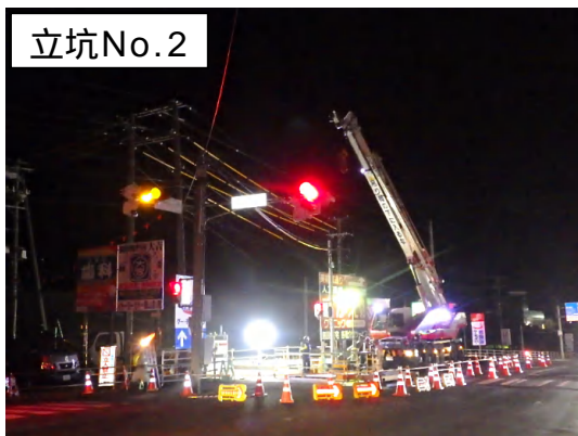
仮設土留撤去状況
