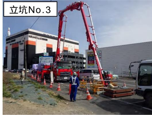
特殊人孔築造(底盤コンクリート打設)状況
