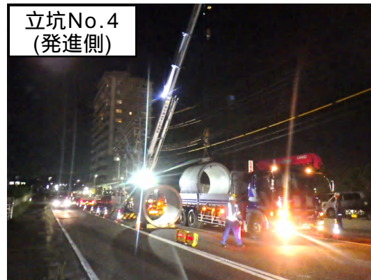
推進工法(ヒューム管搬入)状況
