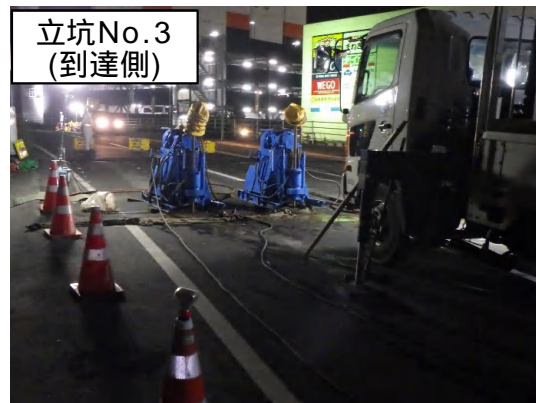
地盤改良(薬液注入)状況
