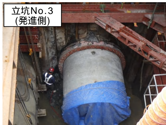
坑口処理(コンクリートはつり)状況
