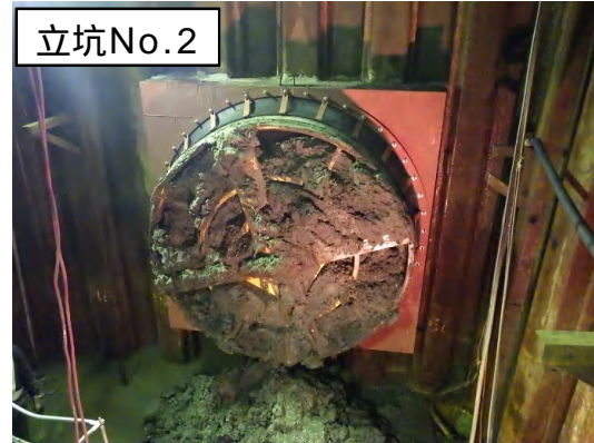
推進工法(掘進機到達)状況
