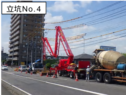
基礎コンクリート打設状況
