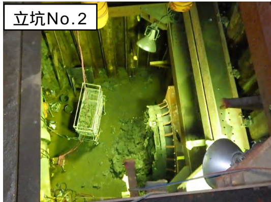
推進工法(掘進機到達)状況
