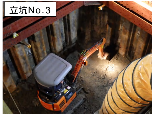
掘削(支保工)状況
