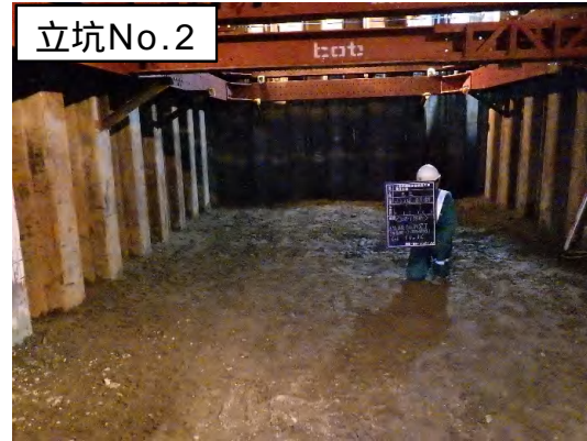
掘削(支保工)状況
