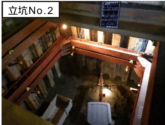
掘削(支保工)状況
