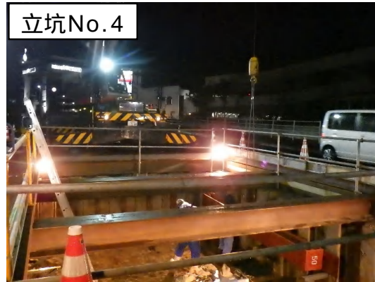
掘削(支保工)状況
