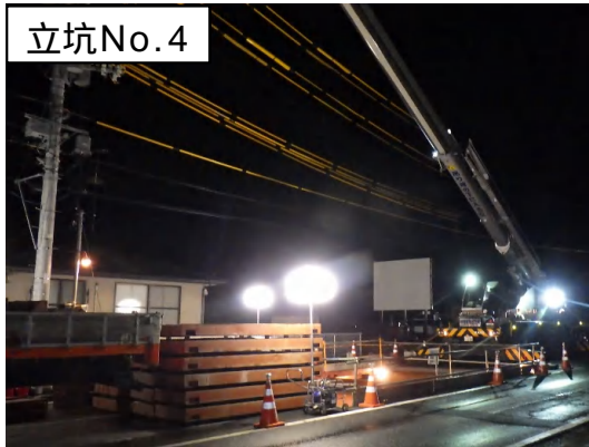
覆工板設置状況
