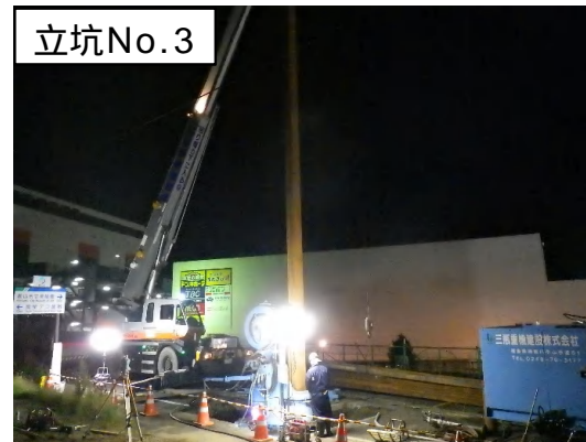
鋼矢板設置状況
