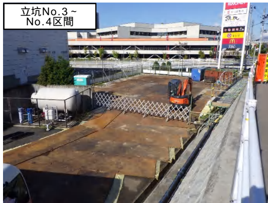
仮設土留工及び推進工事に係る作業ヤード整備状況
