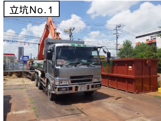
掘削・残土積込状況
