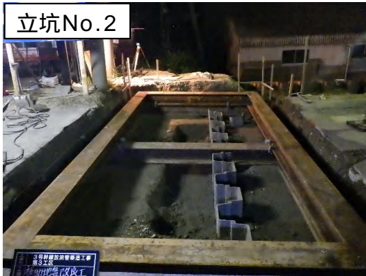
地盤改良用の覆工板設置状況
