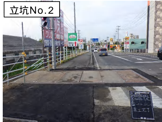
地盤改良用の覆工板設置完了状況
