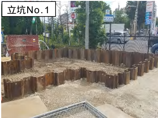
鋼矢板設置完了状況
