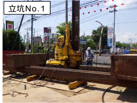
鋼矢板設置状況
