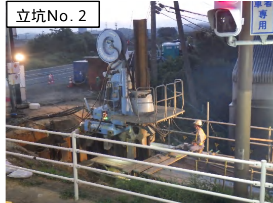
鋼矢板設置状況
