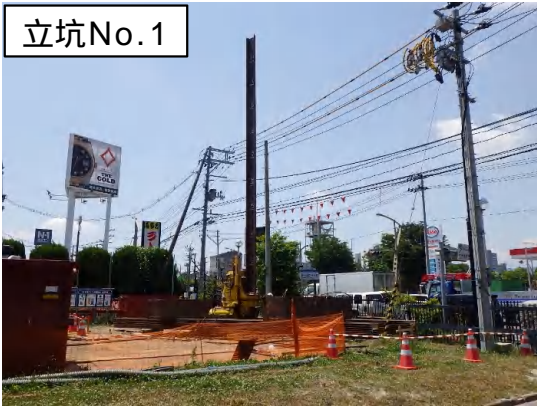
鋼矢板設置状況(全景)
